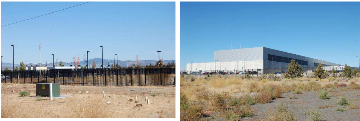
Figure 20. Data center d'Apple et Facebook, Prineville Crédits=© Cécile Diguet et Fanny Lopez, 2018.
