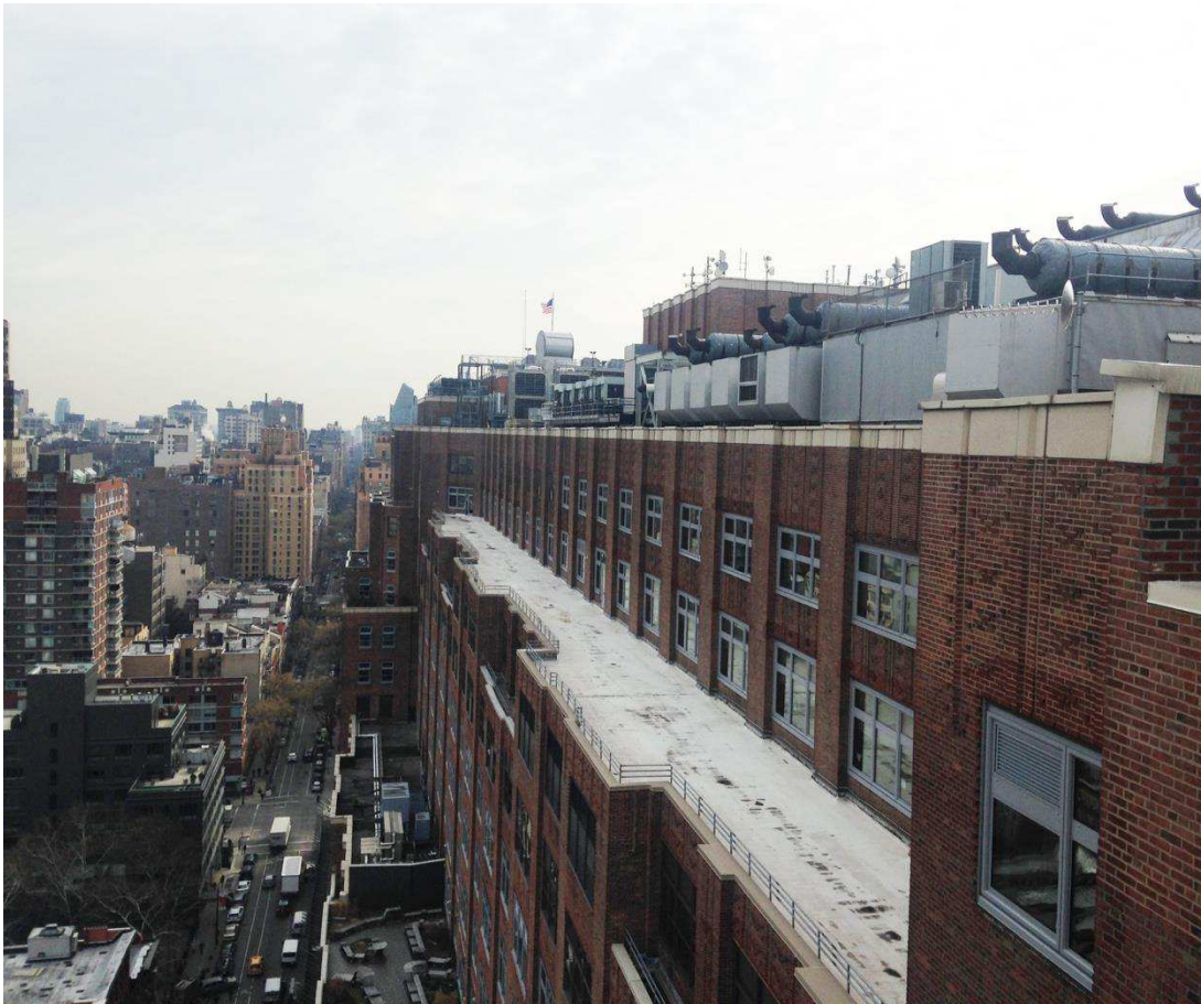
Figure 24. Toiture du 111 8th avenue Crédit =©Cécile Diguët et Fanny Lopez, 2018.
